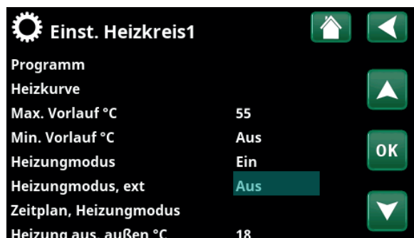
Menü: „Erweitert/Einstellungen/Heizkreis/Heizkreis 1“. Fernsteuerung „Aus“ wird bei Schließung der Reihenklemme K24 aktiviert.
