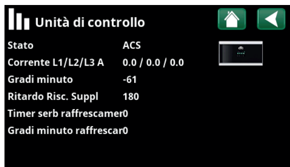
Menù "Dati funzionamento/Unità di controllo".
